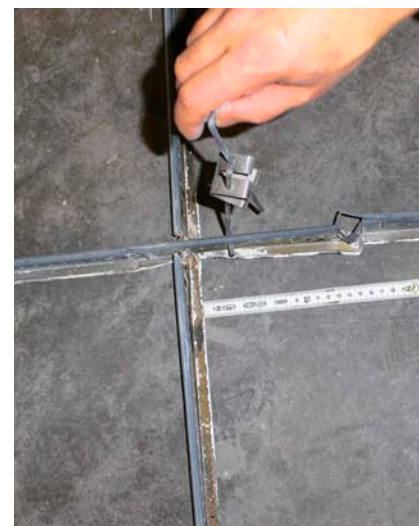
Firebreak in Trulok-profiel heeft de uitzetting van het staal succesvol 'opgevangen'. (Foto: Armstrong)
