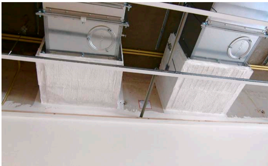
Aangeheeld luchtkanaal vanaf de brandklep tot de brandscheiding met Firetect PA board. (Foto: KLF)
