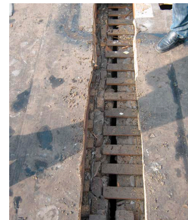
Bovenaanzicht van een open gezaagd dak ter plaats van de bouwmuur; het regelwerk van het originele plafond (stuc op riet) is zichtbaar. Herstel is nodig om de WBDBO te borgen.
