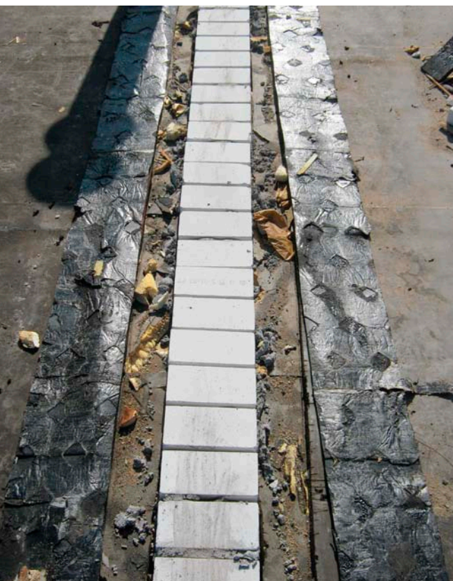
De dakbalken worden ingekort, waarna het bouwdeel wordt opgemetseld.
