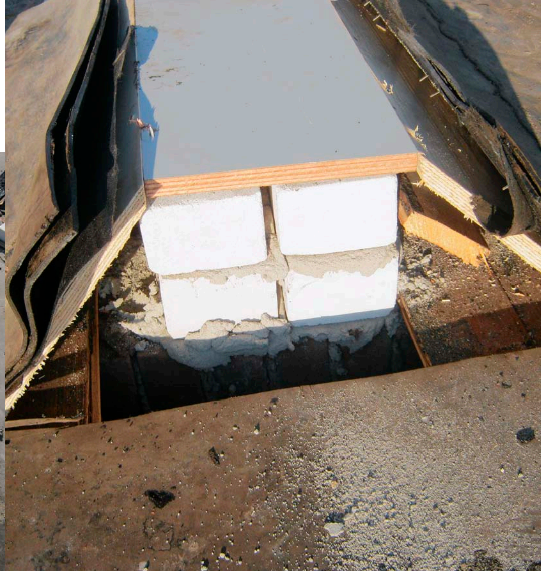
Het opgemetselde bouwdeel wordt afgetimmerd met multiplex.
