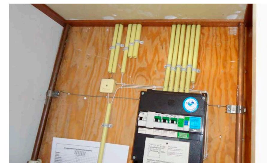
Om de elektrahuizen in de meterkast rookdicht te maken, kan een brandwerende opschuimende acryltaakit worden gebruikt.
